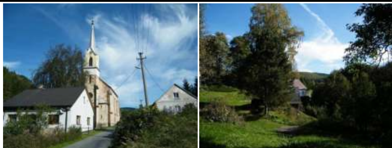
fotodokumentace (Foto: Atelier V, 2011)
