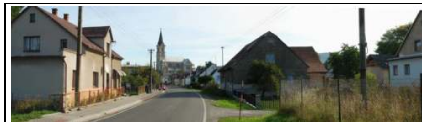
fotodokumentace (Foto: Atelier V, 2011)
