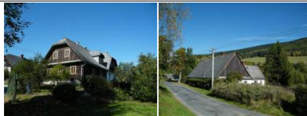
fotodokumentace (Foto: Atelier V, 2011)
