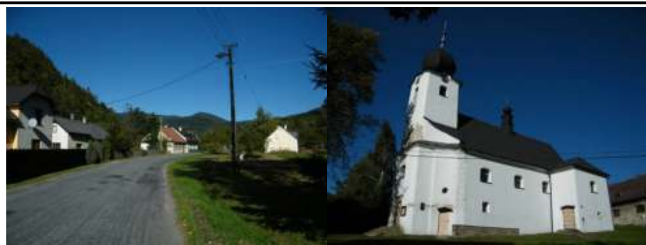
Fotodokumentace (Foto: Atelier V, 2011)
