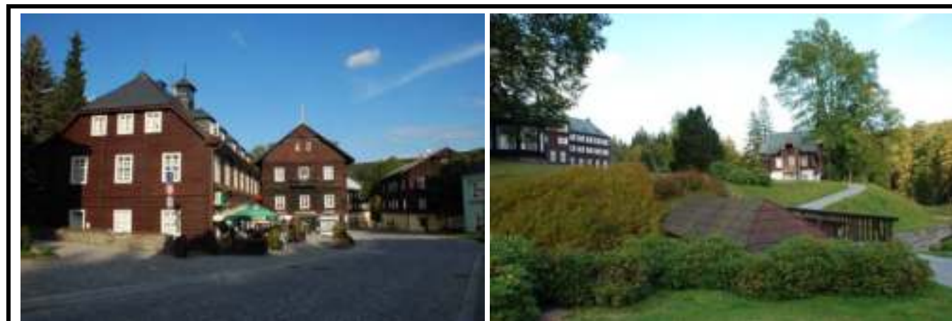
Fotodokumentace (Foto: Atelier V, 2011)
