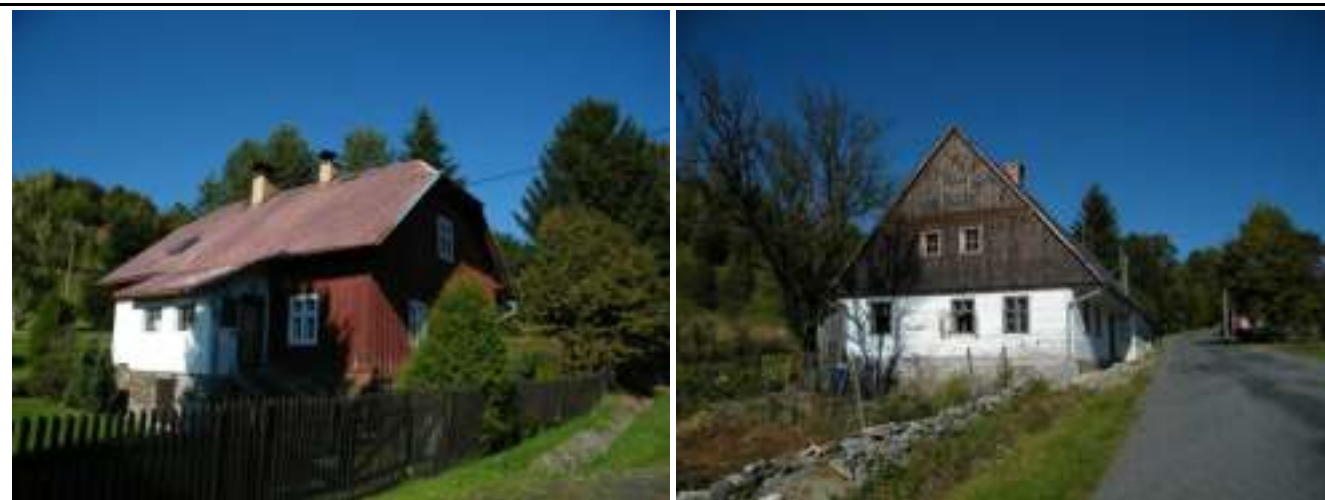
fotodokumentace (Foto: Atelier V, 2011)
