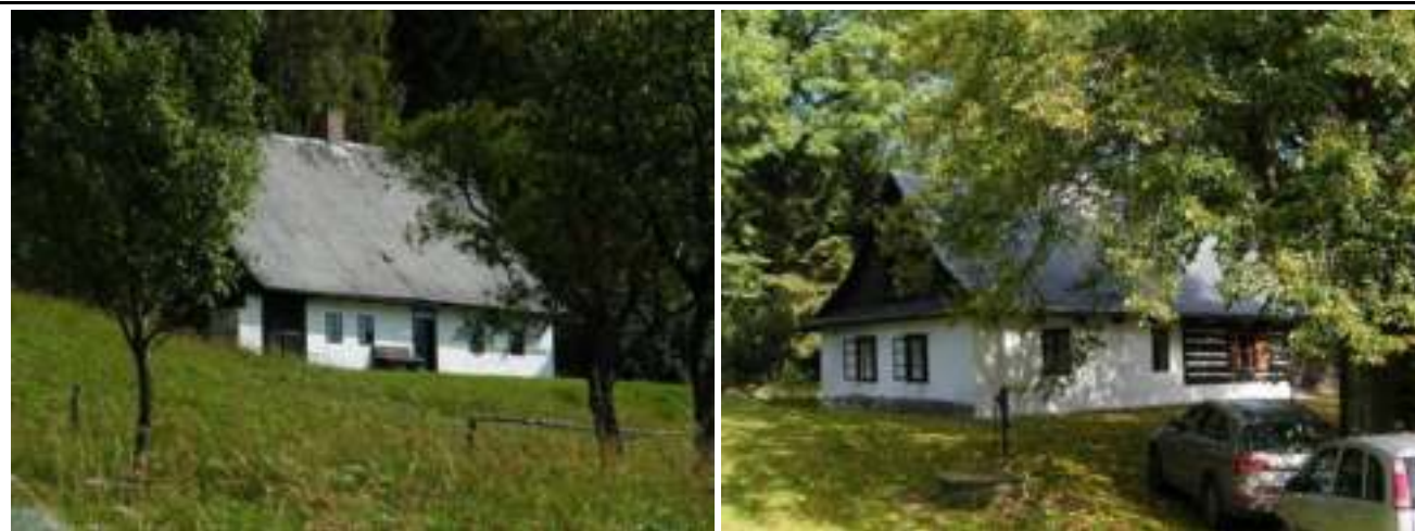
fotodokumentace (Foto: Atelier V, 2011)
