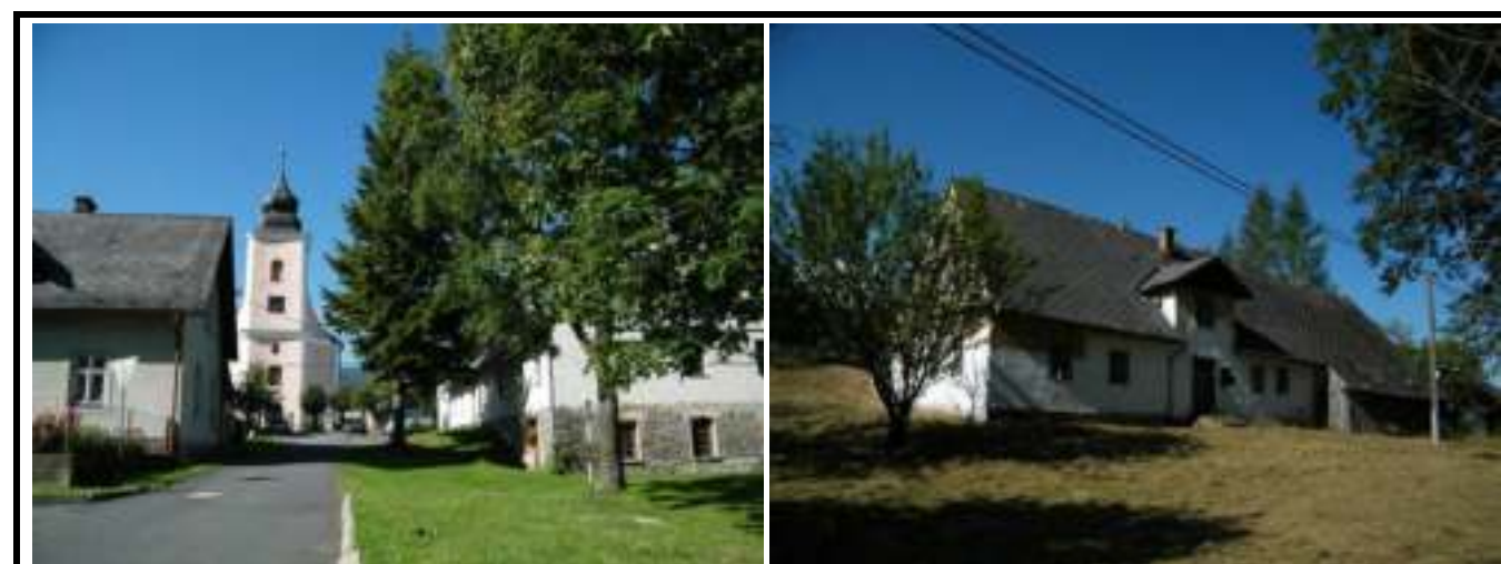
fotodokumentace (Foto: Atelier V, 2011)
