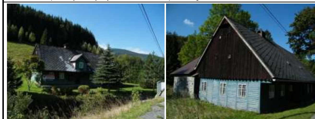
fotodokumentace (Foto: Atelier V, 2011)
