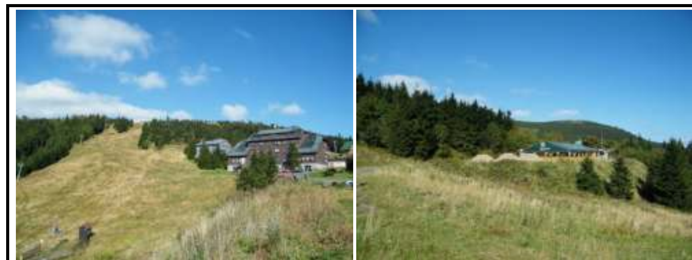
Fotodokumentace (Foto: Atelier V, 2011)
