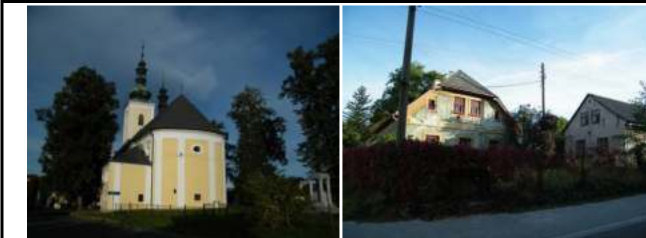
fotodokumentace (Foto: Atelier V, 2011)
