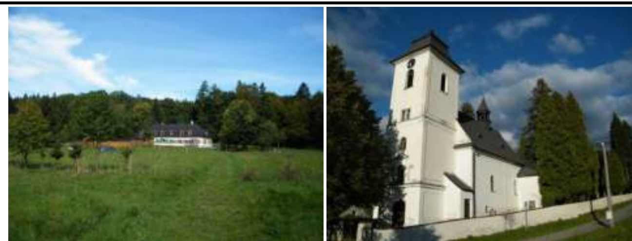
fotodokumentace (Foto: Atelier V, 2011)
